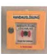
Der Serverraum, Raum 610 in der 6. Etage (Technikgeschoss), wird durch eine selbsttätige Argon-Löschanlage geschützt. Die Argon-Löschanlage wird von Rauchmeldern im Serverraum selbsttätig oder durch Betätigen des nichtautomatischen Brandmelders manuell ausgelöst.
