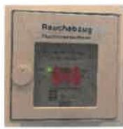
Im Bereich der Fluchtwiege, äu eres Treppenhaus, Erdgeschoss sowie im 9. OG und im Installations- und Aufzugsschacht befinden sich Rauchabzugs- anlagen (RWA). Die RWA des Installationsschachtes wird im Bedarfsfall automatisch durch die Brandmeldezentrale ge offnet.
